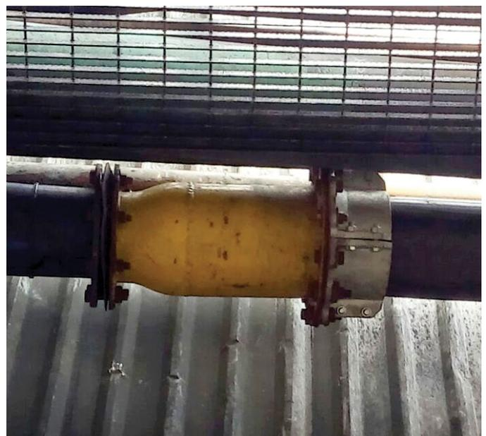
Transición Pexgol 10" a reductor de acero revestido 10"x8" existente.
