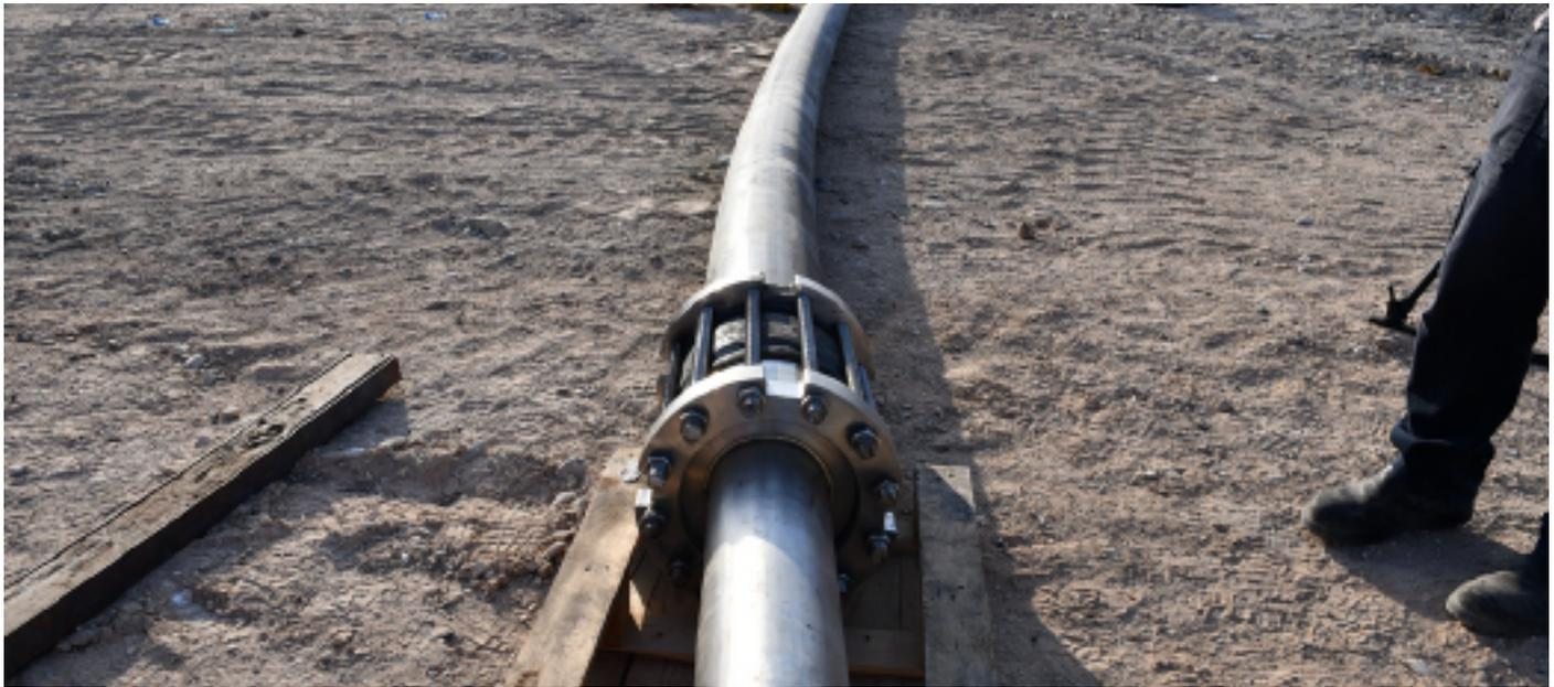
Instalación de tubería Pexgol para el transporte de salmuera a alta presión en un pozo.
