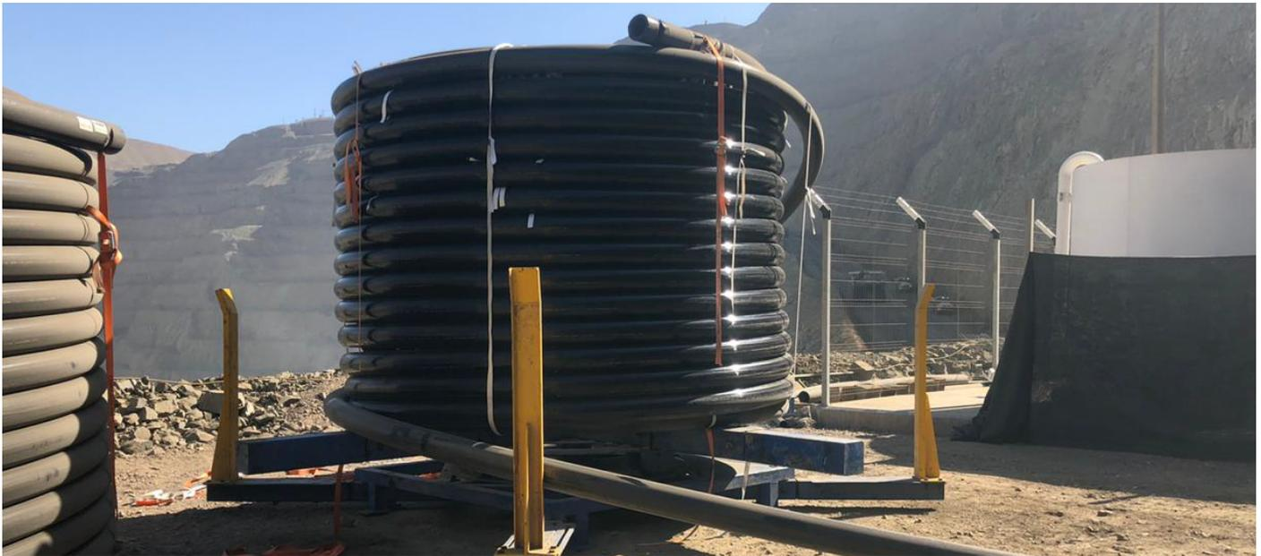
Instalación de 3000 metros de tubería PE-X para una mina subterránea.
