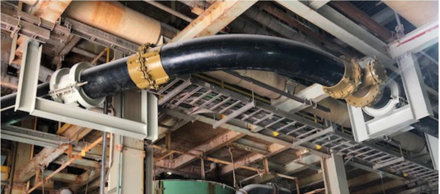
Instalación de tubería Pexgol para una línea de transporte de salmuera caliente.
