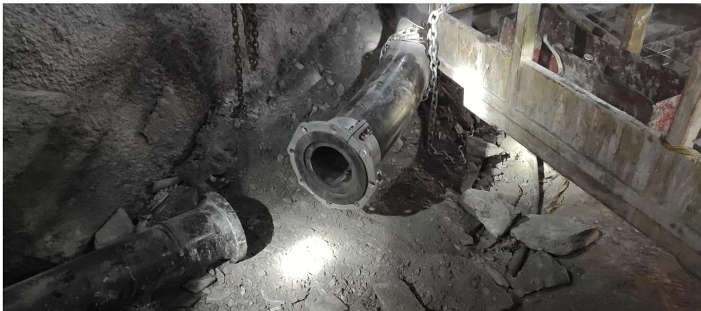
Трубы Pexgol для транспортировки сточных вод при температуре 30 °C / 86 °F в подземном руднике.
