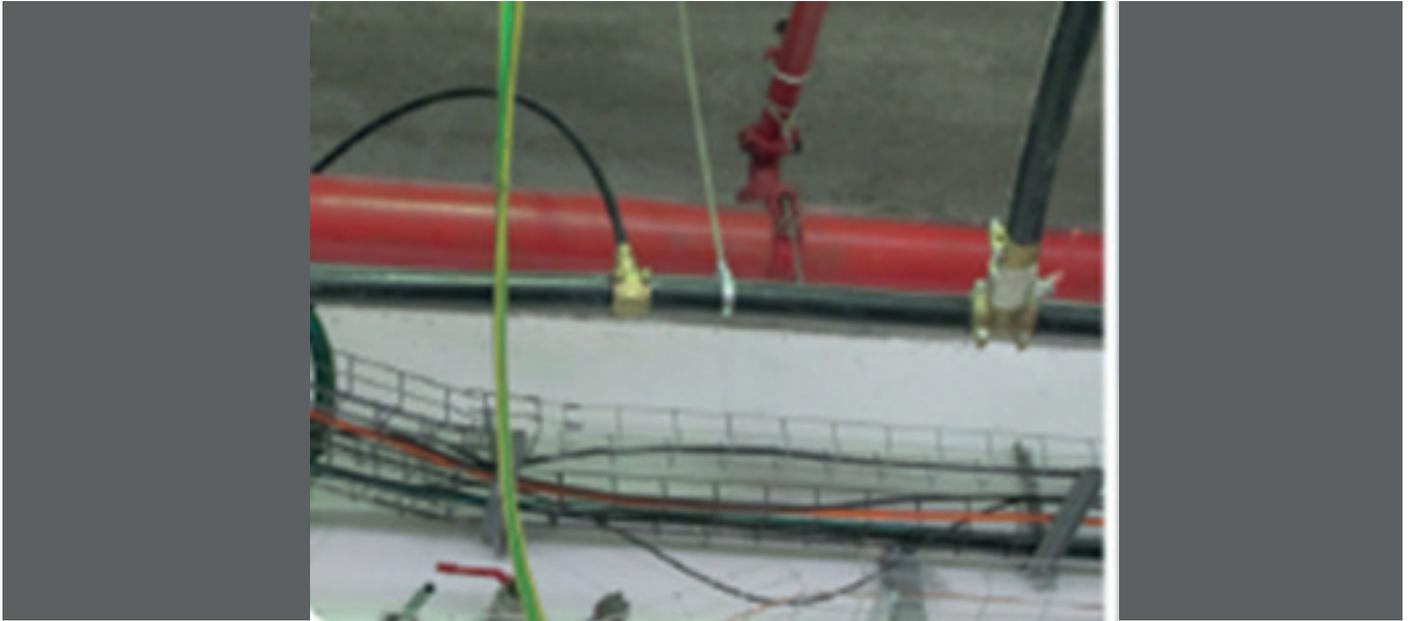
Instalación de tuberías Pexgol para un sistema de aire comprimido.
