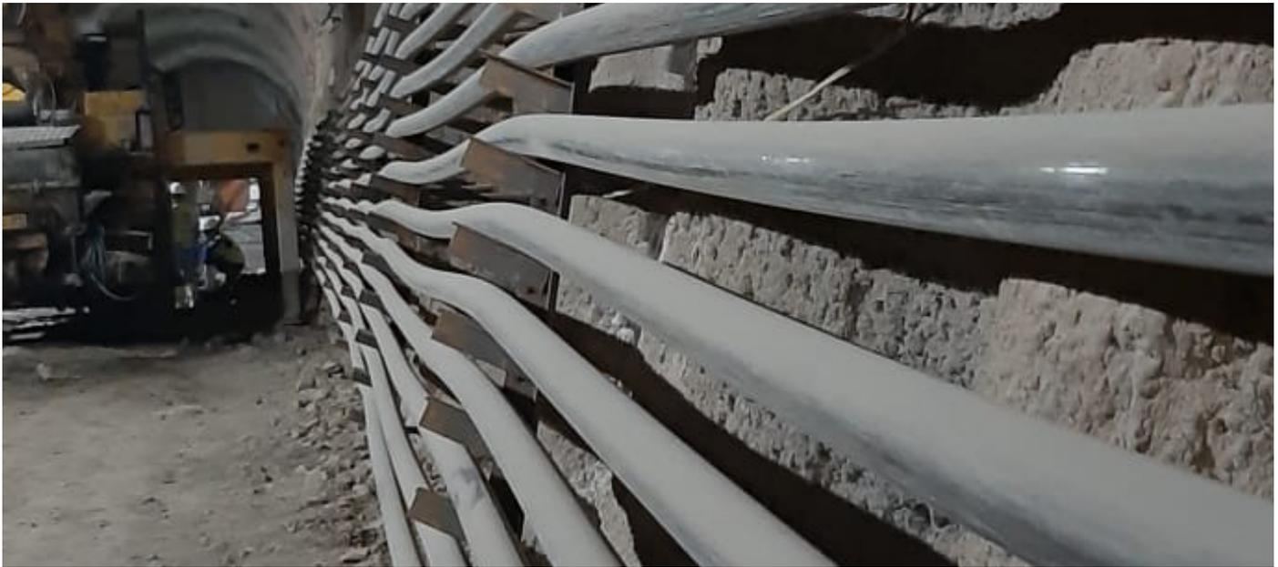
Instalación de tubería Pexgol para transporte de cables de fibra óptica.
